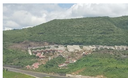
Fig. 1.- Deslizamiento en el coluvión de basaltos y andesitas en la residencial ciudad del Angel en Tegucigalpa (foto agosto de 2016). Foto: G. Suárez.
