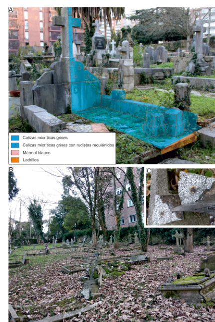
Fig. 3.- A) Panteón realizado con calizas urgonianas grises, con alguna placa de mármol blanco; B) Sepulturas de suelo realizadas con prefabricados de hormigón armado con el árido de mármol blanco; C) Detalle del hormigón armado. Ver figura en color en la web.
