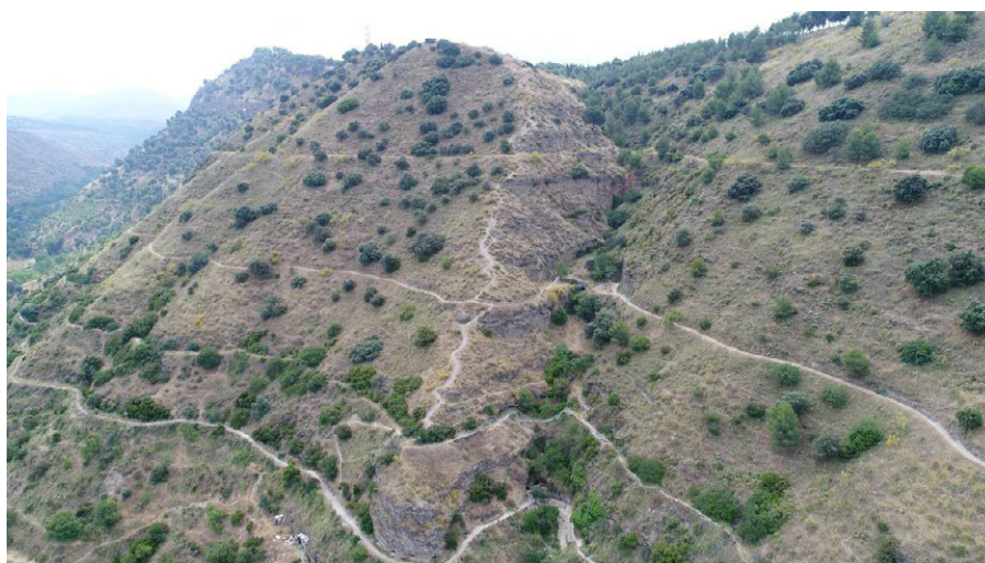
Fig. 2.- Vista aérea del barranco del Aljibe de la Lluvia que desciende desde el Cerro del Sol al valle del río Darro, atravesado por diversas canalizaciones de la Alhambra, en cuya cabecera se encuentra la cisterna que le da nombre.
