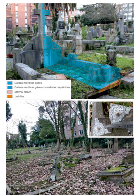
Fig. 3.- A) Panteón realizado con calizas urgonianas grises, con alguna placa de mármol blanco; B) Sepulturas de suelo realizadas con prefabricados de hormigón armado con el árido de mármol blanco; c) Detalle del hormigón armado. Ver figura en color en la web.
