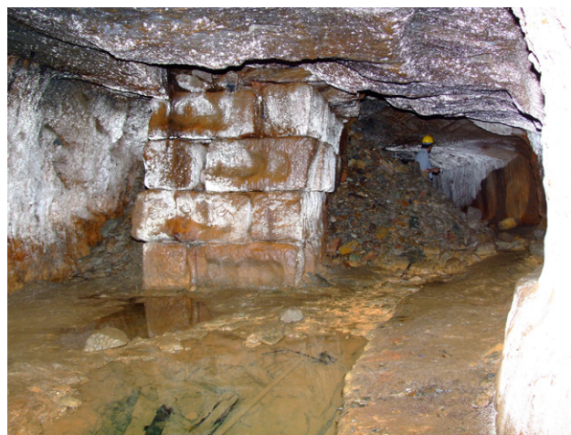
Fig. 9.- Galería do Pilar (Tresminas-Portugal). El pilar ha sido realizado con bases de molinos múltiples de granito.
