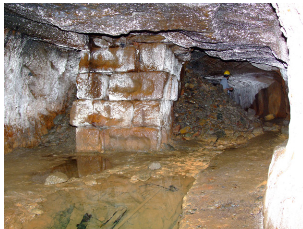
Fig. 9.- Galería do Pilar (Tresminas-Portugal). El pilar ha sido realizado con bases de molinos múltiples de granito.
