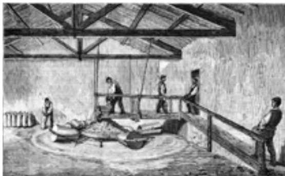
Figura 5. Molienda del yeso en la fábrica de Roux en Vallecas.
