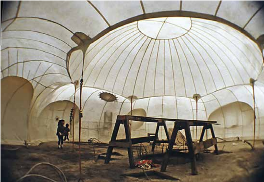
FIG. 6 / Imagen de la cimbra hinchable de la casa flor, en fase de construcción
