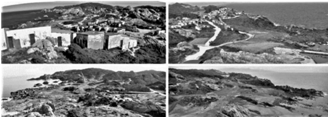
FIG. 5 / Parque Natural del Cap de Creus (Girona), Estado preliminar (arriba) y posterior (abajo) de las obras de desconstrucción del Paratge de Tudela - Tulipán (Club Med)
