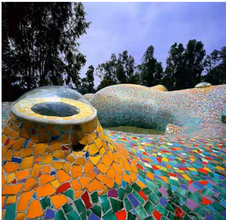
FIG. 7 / La técnica del "Trecandís" utilizada para el revestimiento de la cascara de una de las viviendas mexicanas
