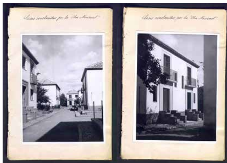
Fig. 3 / Fotografías originales de las obras de la primera fase del grupo de la carretera de la Sierra, anónimo, 1938
