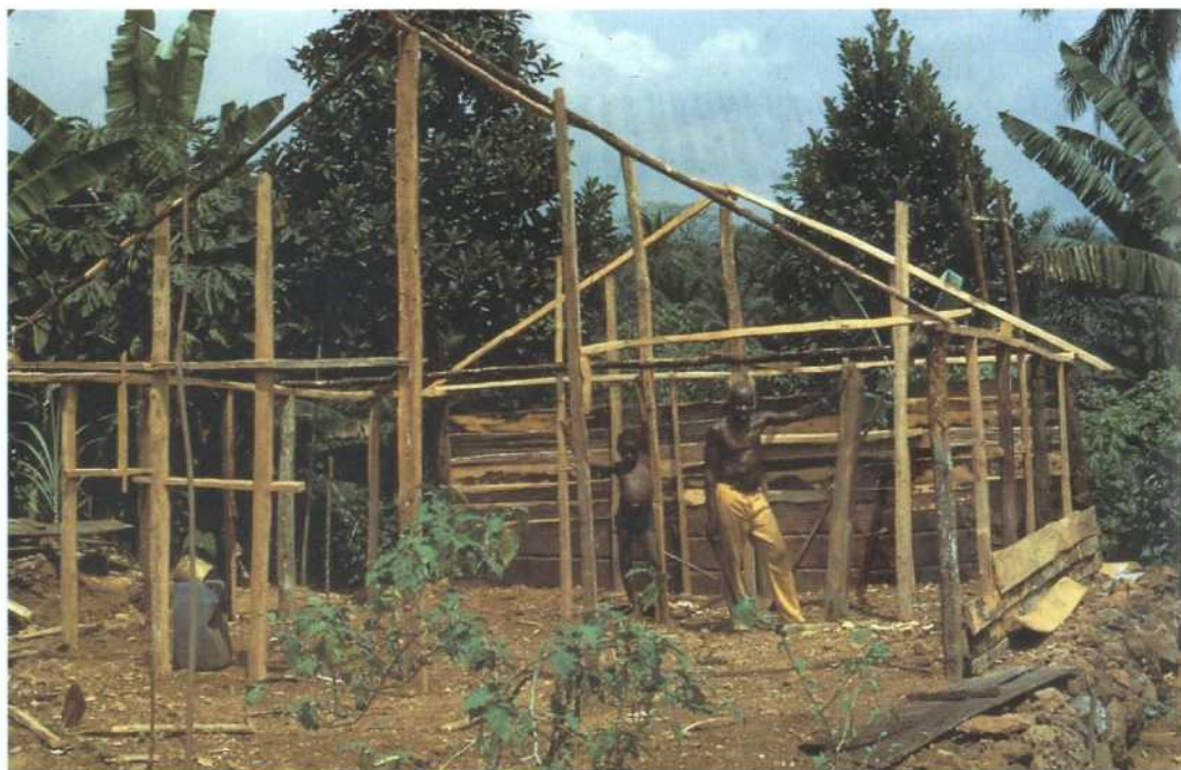
Foto 2: Casa en construcción. La estructura interior marca la división entre las dos estancias que constituyen la casa (cocina y dormitorio). (6)
