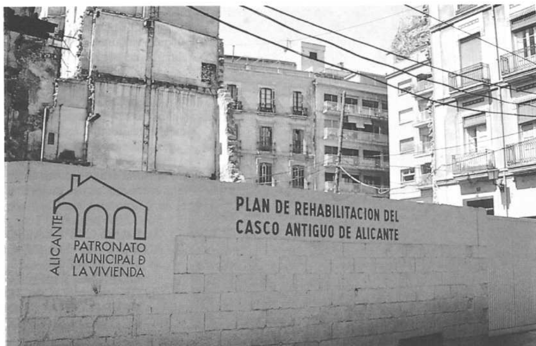
Actuaciones de demolición incluidas en el Plan RACHA (Plan de Rehabilitación del Casco Antiguo de Alicante).
