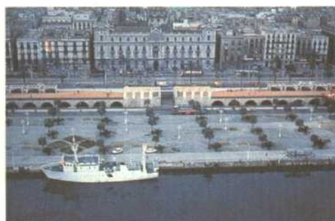
Figura 15. Moll de la Fusta después de la transformación. El tráfico de paso circula semideprimido y el espacio principal es asignado a la circulación urbana y a los peatones.
