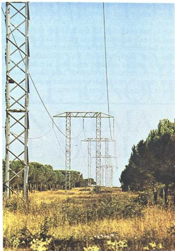
Fig. 20. Los tendidos de alta tensión en un área forestal han obligado a la apertura de una amplia zona de seguridad. Portillo.
