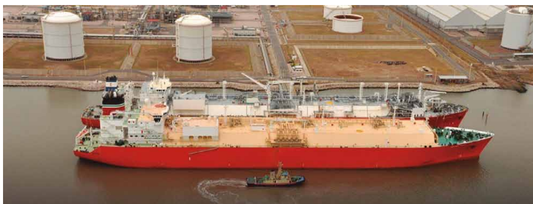
Fig. 3/ Buque Excelsior, unidad flotante de regasificación de Gas Natural Licuado en Puerto Galván.
