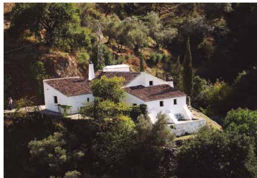
Fig. 5.2/ Las Casillas. Restauración para casa rural de lagar campesino.
