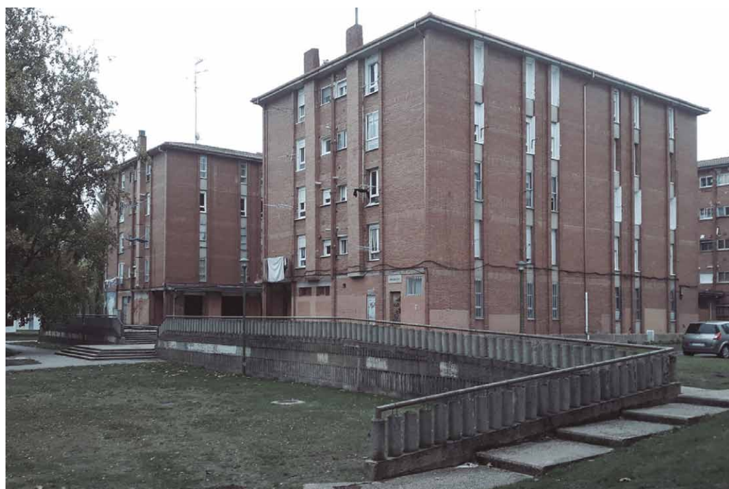
Fig. 1/ Estado preoperacional del barrio.
