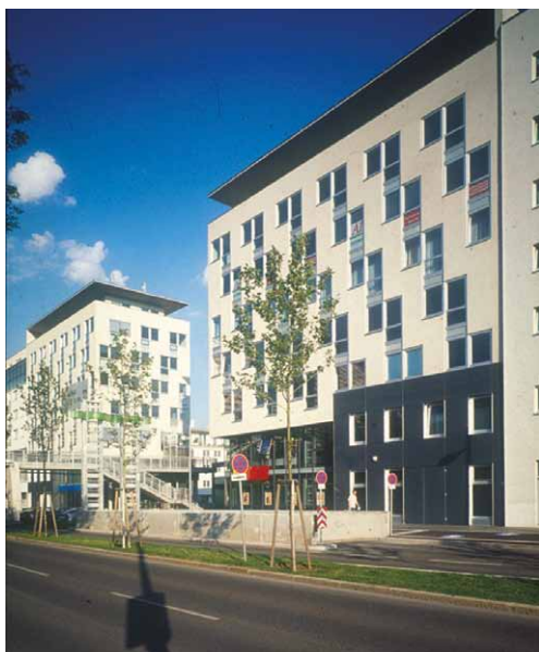
Fig. 10/ Calle Anton Baumgartner, edificio de oficinas.
