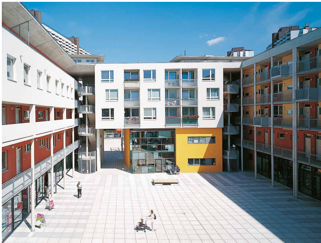
Fig. 15/ Patio interior abierto de manzana en el tramo derecho, alojamiento intergeneracional.
