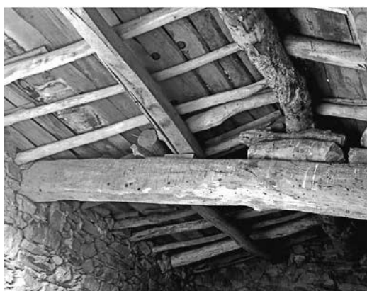
FIG. 14/ Detalles de estructuras para formación de cubierta a dos aguas. A izquierda edificación ligada a pastos en las estribaciones. A la derecha edificación ligada a explotación en la vega del Tajo
