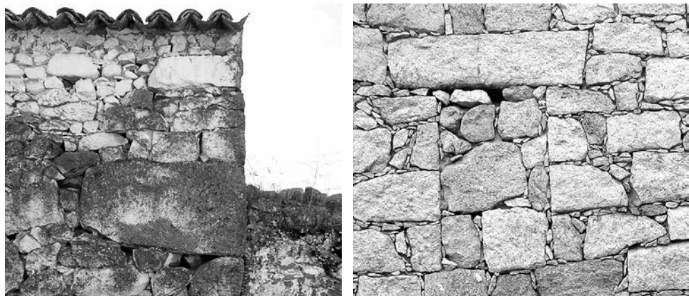
Fig. 11/ Imágenes de fábricas de mampostería de granito a orillas del río Pusa y en el entorno del río Torcón
