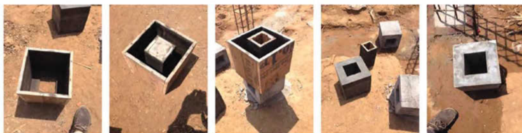
FIG. 7/ M.A.C. Arriba: asamblea de la comunidad local. Abajo: los bloques utilizados como parte del encofrado para los pilares de fundación.
