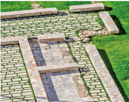
FIG. 14, 15/ Detalles del antiguo y el nuevo pavimento con los muros que evocan el antiguo trazado del convento reciclando los restos arqueológicos provenientes de la demolición (Vicente A. Jiménez).
