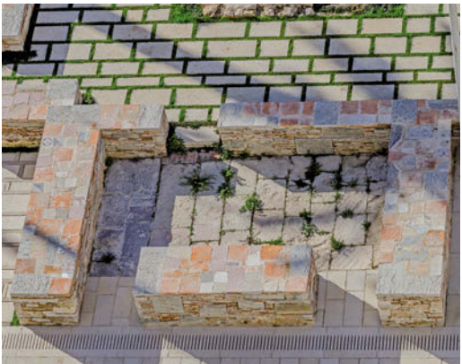
FIG. 14, 15/ Detalles del antiguo y el nuevo pavimento con los muros que evocan el antiguo trazado del convento reciclando los restos arqueológicos provenientes de la demolición (Vicente A. Jiménez).
