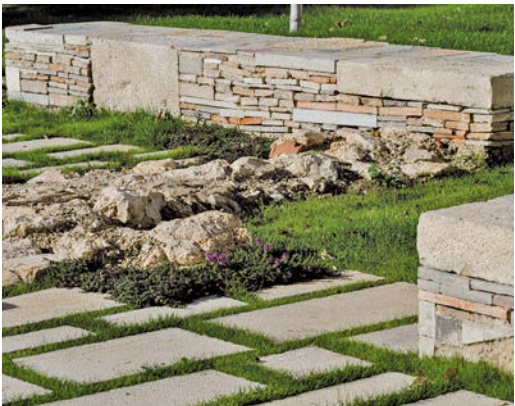
FIG. 13/ Restos de los antiguos muros emergiendo entre los nuevos erigidos con los antiguos materiales de construcción reciclados (Vicente A. Jiménez).
