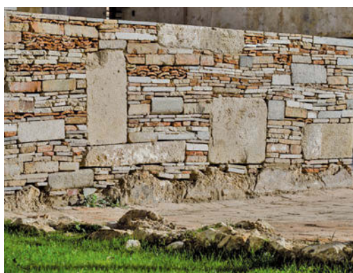
FIG. 9, 10/ Detalle de los muros contruidos con los escombros de la demolición del convento aparejados en seco (Vicente A. Jiménez).
