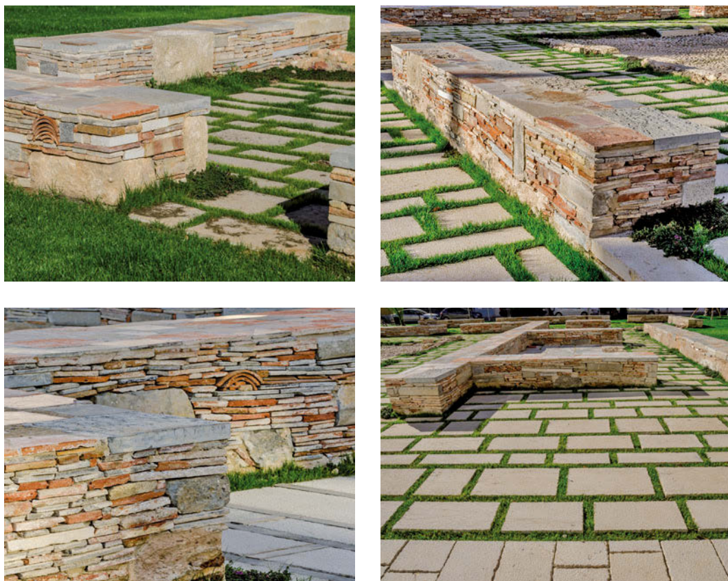
FIG. 4, 5, 6, 7/ Vistas de los pequeños muros que evocan el trazado del convento usando los fragmentos de su demolición, los pavimentos antiguo y nuevo y la vegetación que crece en los espacios intersticiales (Vicente A. Jiménez).
