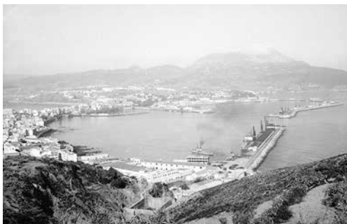
FIG. 2/ Vista de Ceuta desde el monte Hacho en los años treinta. De izquierda a derecha se observa la ciudad histórica, desarrollada en el istmo peninsular que une al monte Hacho con el Campo Exterior, y la zona portuaria
