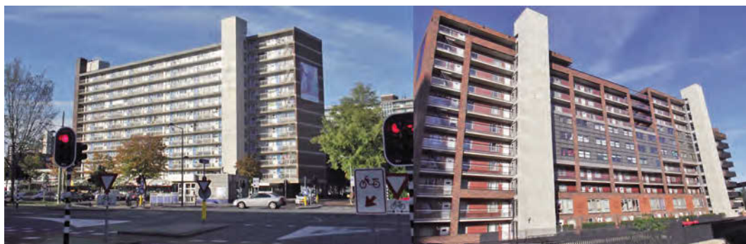
Los bloques de 11 plantas antes y después de la remodelación
