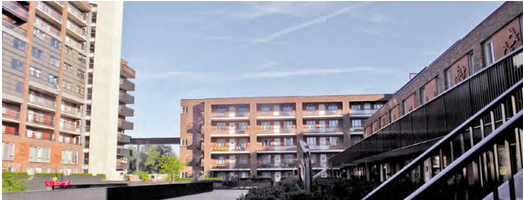
Diversidad tipológica en el edificio de 11 plantas remodelado y en los nuevos edificios que conforman la manzana. Acceso a las viviendas desde el patio de manzana de acceso público
