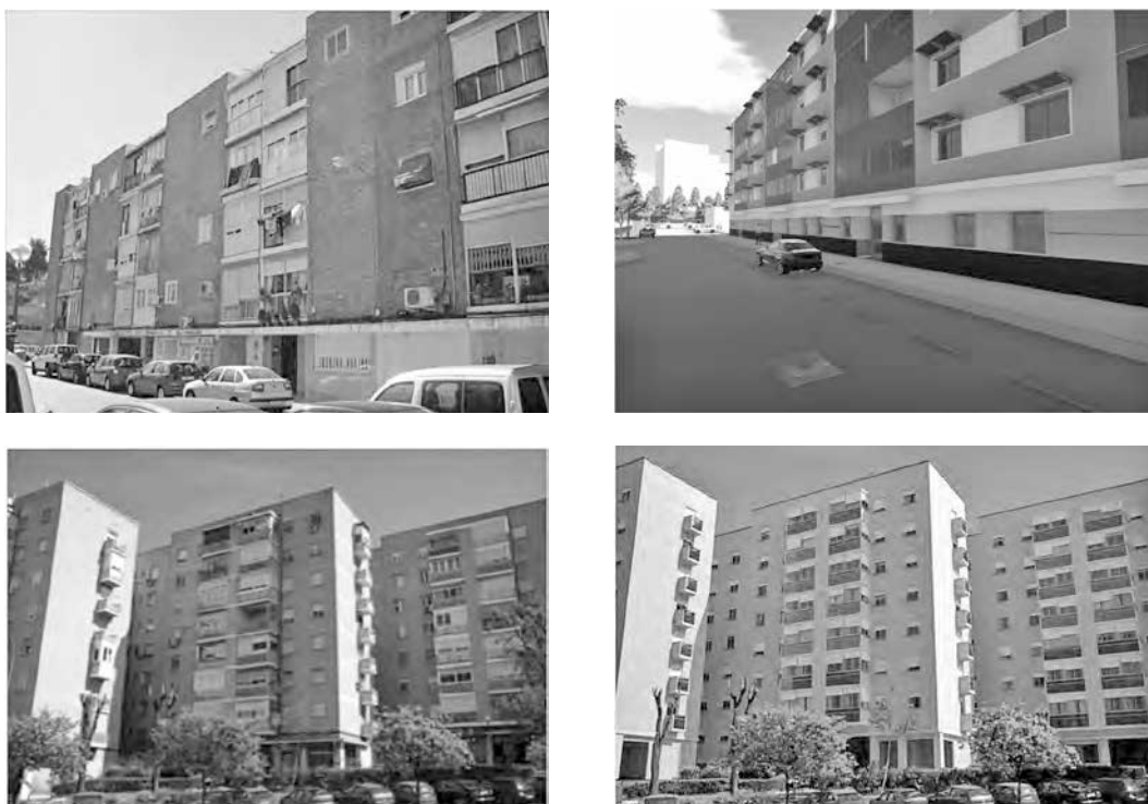
FIG. 2/ Ejemplos de infografías (antes/después del proceso de rehabilitación) Barrio del Pilar, Madrid
