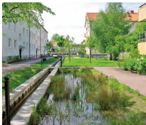
Rediseño de las áreas verdes e integración paisajista de los canales y uno de los estanques del sistema de SUDS
