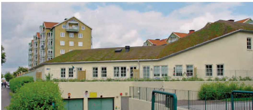
Vista de uno de los edificios para personas mayores, con tejado verde, construido sobre un antiguo garaje
