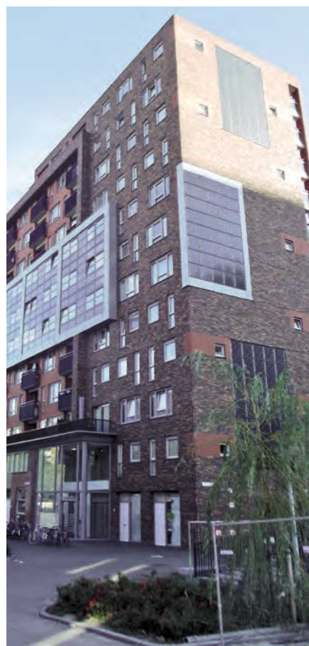
Evaluación y monitorización continua. Edificio remodelado. Paneles fotovoltaicos en fachada de medianera
