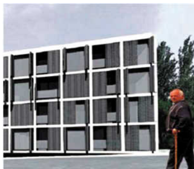
Representación de la fachada a Avenida de las Retamas. Acceso a Servicios Sociales. / El módulo tiene una representación en fachada, que se resuelve con una solución prefabricada de hormigón, que da unidad al conjunto.
