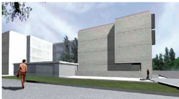
Representación de la fachada a Avenida de las Retamas. Acceso a Servicios Sociales. / El módulo tiene una representación en fachada, que se resuelve con una solución prefabricada de hormigón, que da unidad al conjunto.
