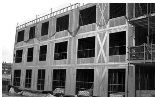
FIG. 13. Momento del montaje de 26 viviendas industrializadas de alquiler para jóvenes en Callús, resultado del Concurso de Innovación Técnica, INCASOL, de la Generalitat de Cataluña, realizadas con el sistema constructivo TECCON con empleo de paneles de entramado a base de perfiles de chapa de acero galvanizado
