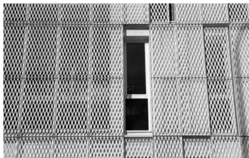
FIG. 18. Detalle de la utilización de paneles móviles a base de metal “deployé” que cubren toda la fachada suroeste de los edificios proporcionando el sombreado de los mismos
