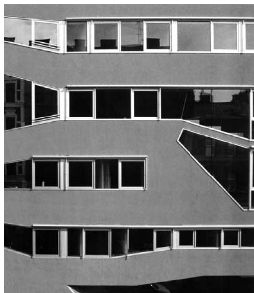
FIG. 7. Acciones tácticas: la fachada revela una sección variada con altura de techo generosa en las habitaciones. Viviendas experimentales en la Missindorfstrasse, Viena. BKK-3
