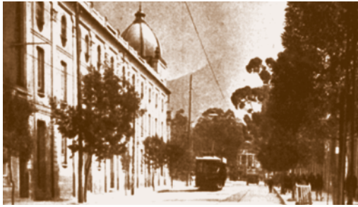
FIG. 7. Tranvía eléctrico Calle 26 (al fondo Parque del Centenario), 1910
