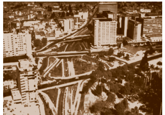
FIG. 12. Vista aérea de los viaductos, 1960
