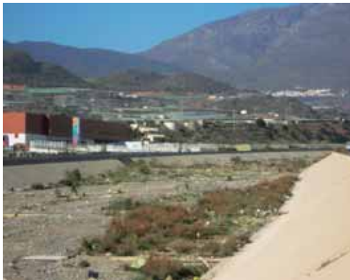
FIG. 6. Encauzamiento de la Rambla de Gualchos.
