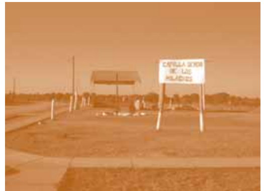
FIG. 11. En la imagen se observa el estado en que se encuentra la construcción de la capilla.
