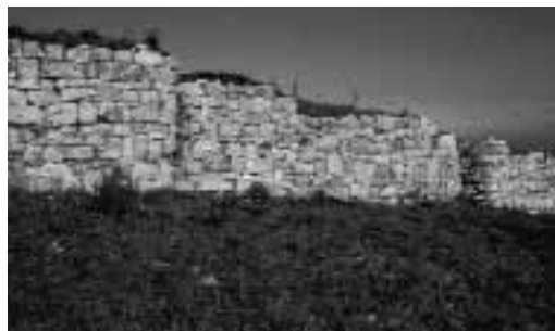
FIG. 3. Construcción castreña. La superposición de piedras configura la muralla de módulos castreña de la Campa de Torres, Gijón
