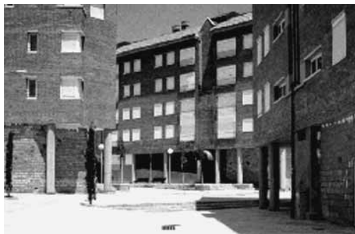
FIG. 4. Grupo de viviendas en la periferia de la ciudad de Tenerife
