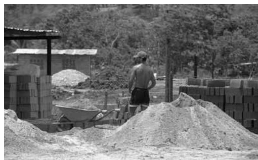
FIG. 21. Taller de producción de bloques y de pequeños elementos prefabricados de hormigón en una de las parcelas de la reciente toma masiva de terrenos (2001) llevada a cabo por tres mil familias en Las Garzas, a unos 20 km de la ciudad de Panamá (foto SALAS).
