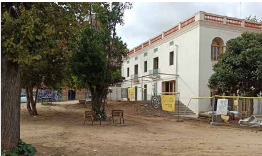
FIG. 4 / Plaza de la Farigola y Can Carol reformada como un centro cívico
