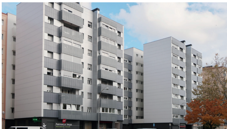
FIG. 6./ Edificios del grupo residencial Orvina II, con la envolvente rehabilitada
