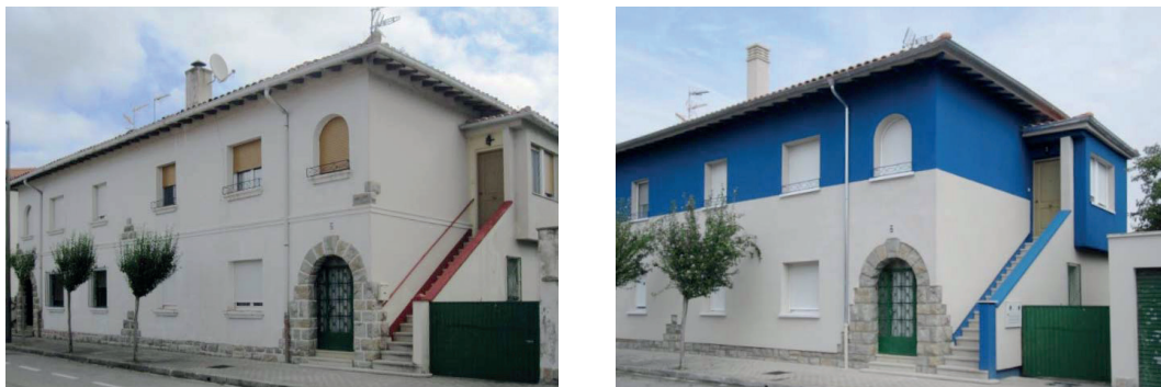
FIG.2./ Vivienda característica del grupo residencial “Calor Txantrea” antes y después de la rehabilitación de la envolvente
