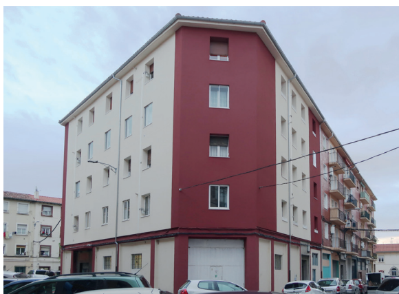
FIG. 4./ Vivienda rehabilitada del grupo residencial Casas Herrera delante de las viviendas del grupo Calor Txantrea
