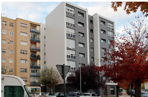
FIG. 3./ Edificios del grupo residencial Orvina III, con la envolvente sin rehabilitar (izquierda) y rehabilitada (derecha)
