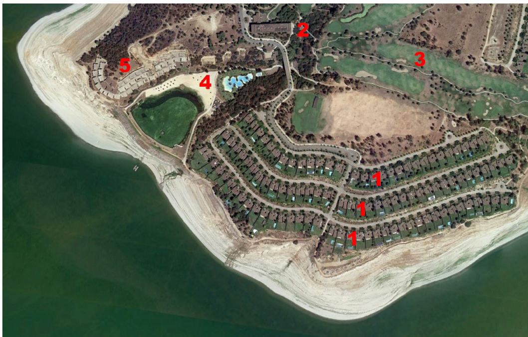
FIG. 3/ Detalle de la zona de la isla de la imagen aérea anterior: 1-Hileras de casas terminadas, 2-Hotel en funcionamiento, 3-Campo de golf, 4-piscinas y playa artificial y 5-Hotel en construcción paralizada
