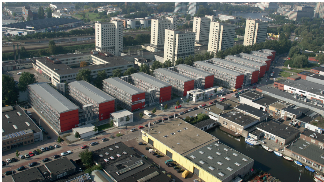
Fig. 7/ Complejo de 1000 unidades de “container” recicladas para estudiantes en el área de la estación de Amstel y la antigua prisión de Bijlmerbajes, Ámsterdam.
