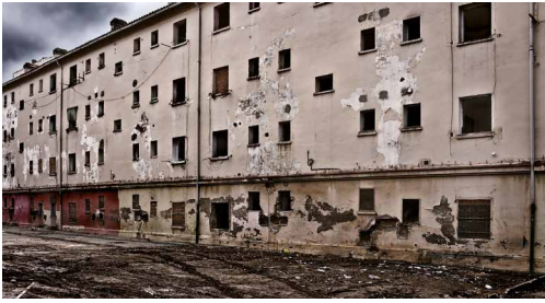
Fig. 22/ Edificio Simancas. Inicio proceso de demolición.
