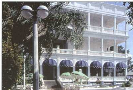
FIGURA 8. Buenaventura, Hotel Estación. 1925.
