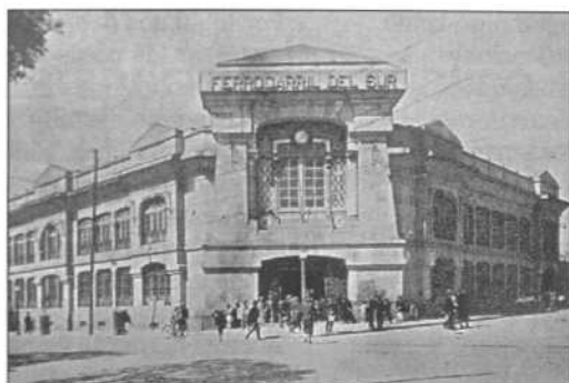
FIGURA 14. Bogotá. Estación del Ferrocarril del Sur. Arq. Pablo de la Cruz, 1926. Fachada.
