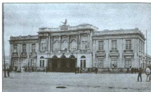
FIGURA 11. Bogotá, Estación de La Sabana. 1914-18.
