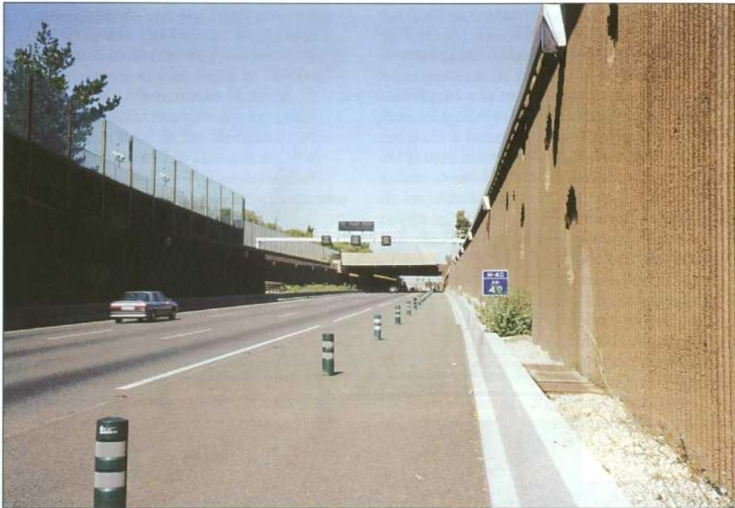
**FIGURA 4:** Una de las «pantallas totales» de protección acústica adoptada, a modo de sombrero, sobre el piso superior de las calzadas superpuestas de la M-40, dentro de la Urbanización Monreal.
