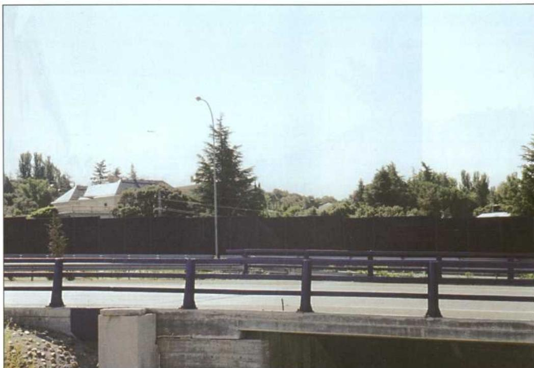
**FIGURA 3: Pantallas metálicas de 2 m de altura dispuestas en ramal de la M-40, sentido Este (hacia la Avda. de la Ilustración), que producen un efecto rebote hacia las propiedades situadas al lado contrario por debajo de la rasante.**
