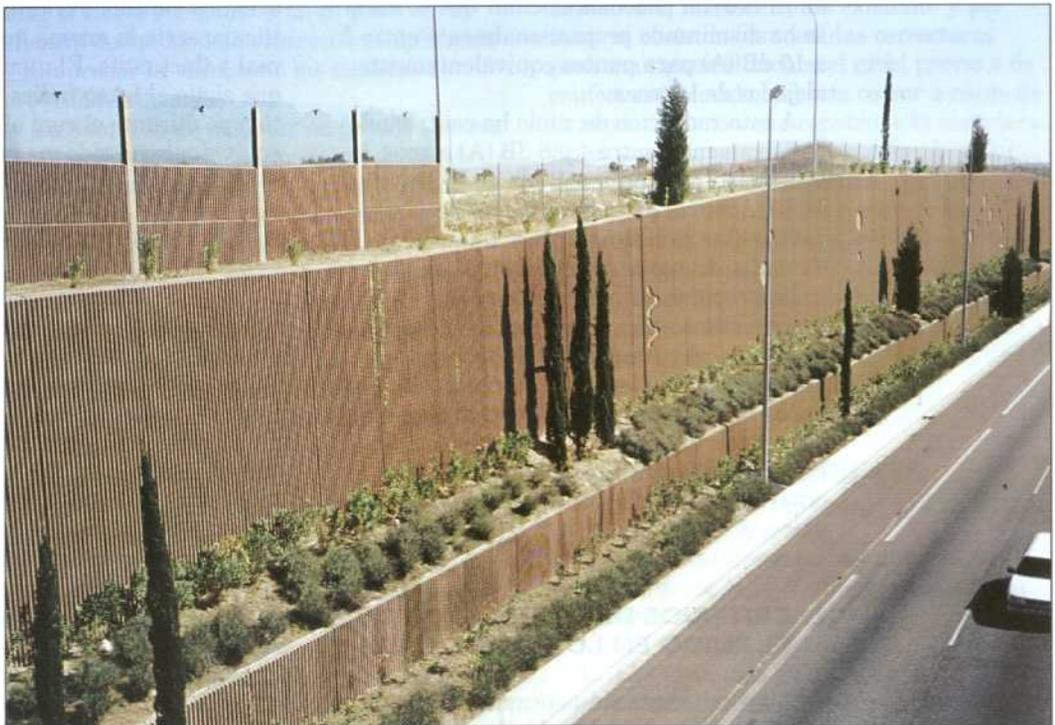
**FIGURA 1:** Varios niveles de pantallas en el tiempo, que discurre en trinchera, por valdemarín. este diseño ha demostrado ser bastante eficaz para reducir el ruido.
