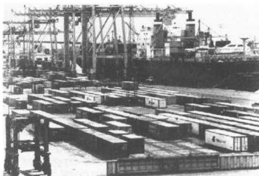
Terminales de contenedores del puerto de Hamburgo.
