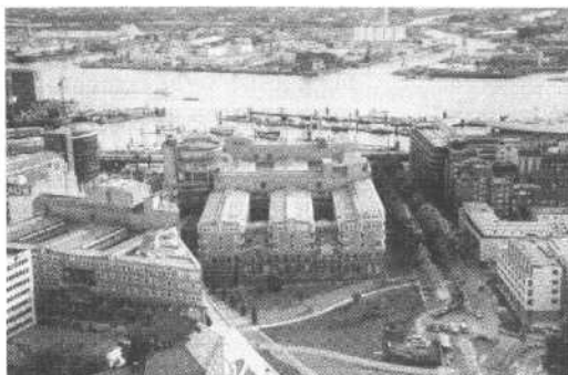
La «Ciudad de los Periodistas», edificio de la editorial Gruner & Jahr (arquitecto: Steidle und Partner); enfrente, el solar del centro comercial Hanseatic Trade Center (fotografía: D. Schubert).
