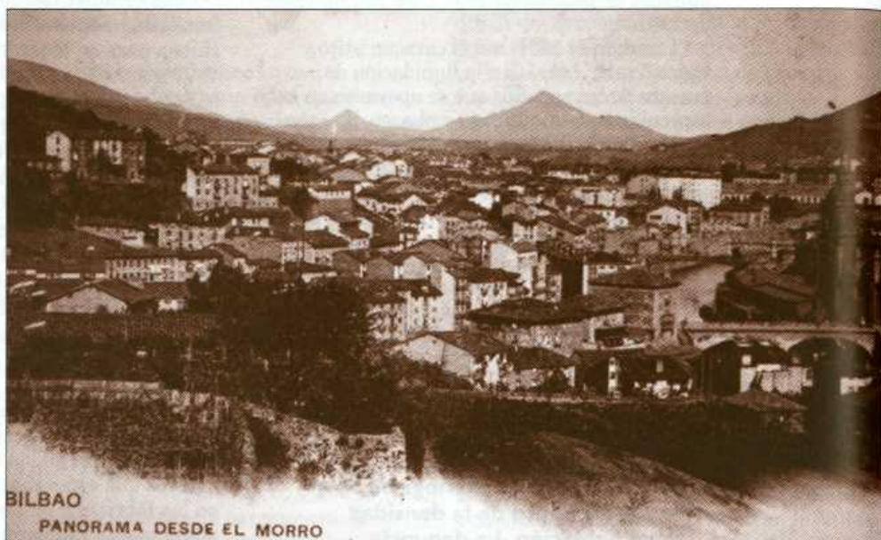
FIGURA 3. Vista de los distritos de San Francisco y Bilbao la Vieja en el entorno del año 1900. Imagen de la densidad de los barrios que bordean el Ensanche. Construcción especulativa y de baja calidad. Fotografía procedente de los fondos del Archivo Foral de Vizcaya. Sección de Fotografía, R.417, nº41.
