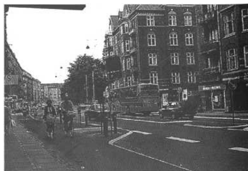
Reducción de calzada en viario principal para crear una pista de bicicletas y ordenar los cruces y aparcamientos. Copenhague.
