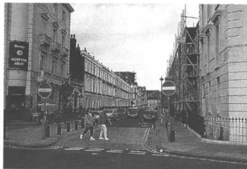
Tratamiento "tranquilo" de una intersección de Londres, reducción y elevación de la calzada, cambio de color y textura, protección contra el aparcamiento.
