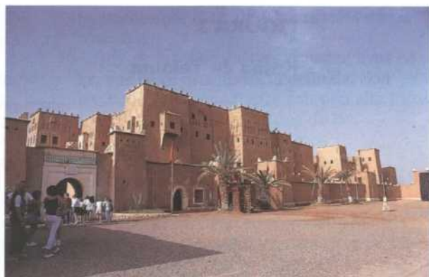
Ouarzazate: Entrada a la Kasba-Ksar, junto a la alcazaba.
