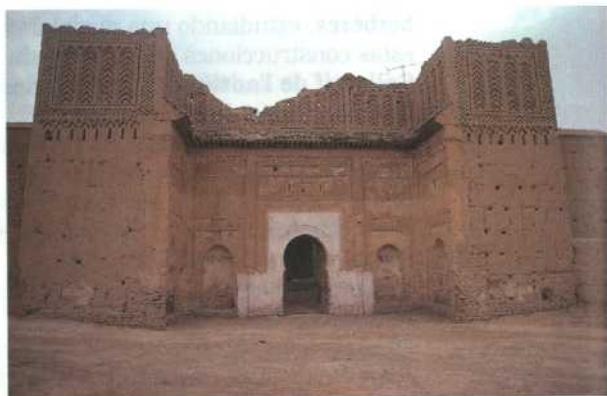
Rissani: Kasba de Oudri Hali (Mouli Rachid). Entrada al serrallo.
