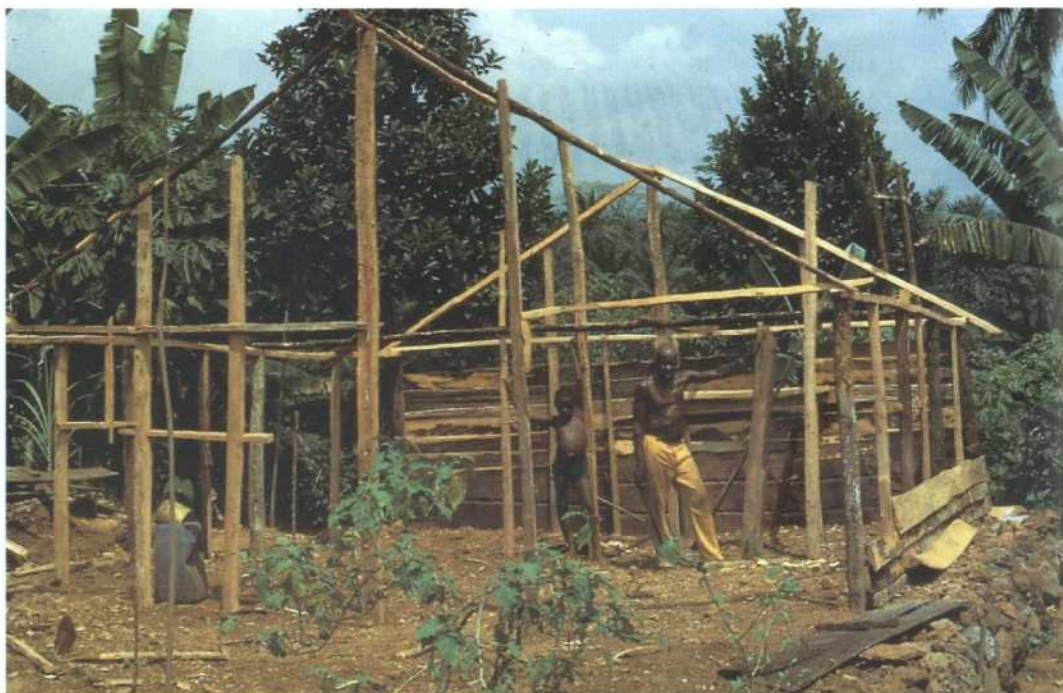
Foto 2: Casa en construcción. La estructura interior marca la división entre las dos estancias que constituyen la casa (cocina y dormitorio). (*)
