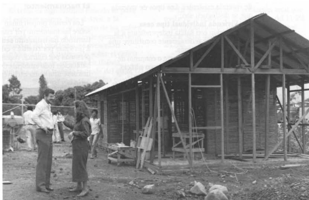
8. Vivienda experimental a base de bambú y madera en el Centro Nacional del Bambú en San José de Costa Rica.
