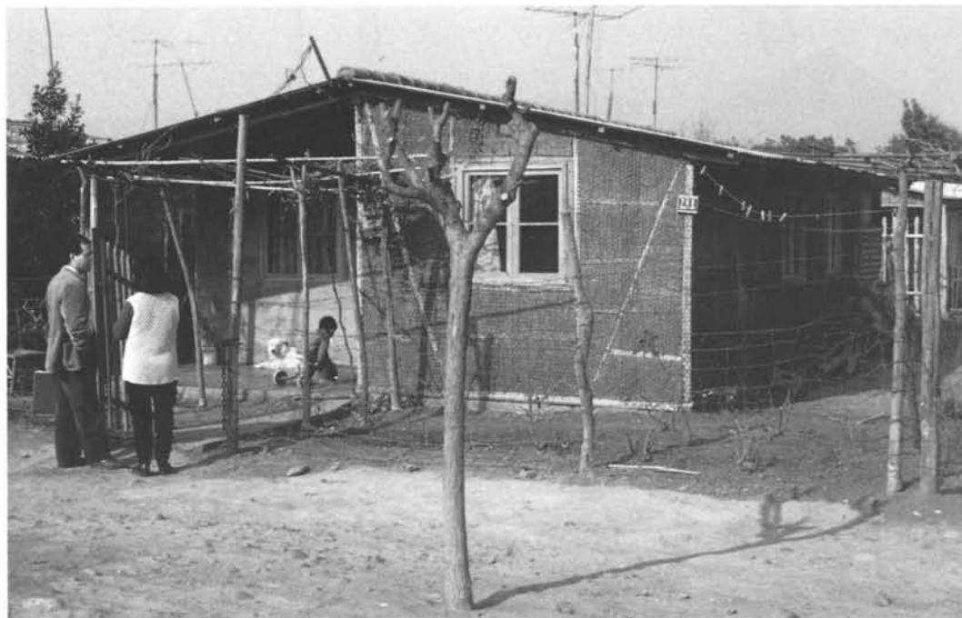
4. Vivienda rural por autoconstrucción a base de madera y tierra, técnica conocida como «bahareque», «torchis», «quincha» ..., según las diferentes regiones geográficas.
