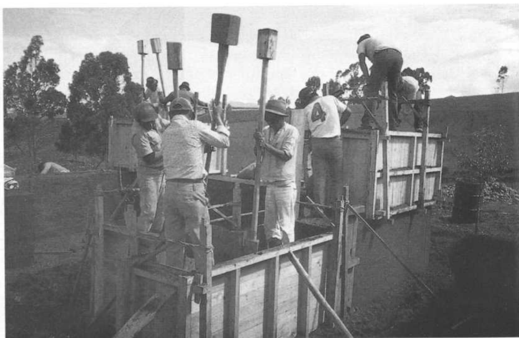
5. Construcción a base de tapiales como técnica dominante en la vivienda rural ecuatoriana.
