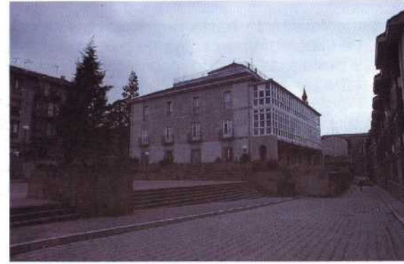
FIG. 9. Edificio rehabilitado para centro social del barrio.
