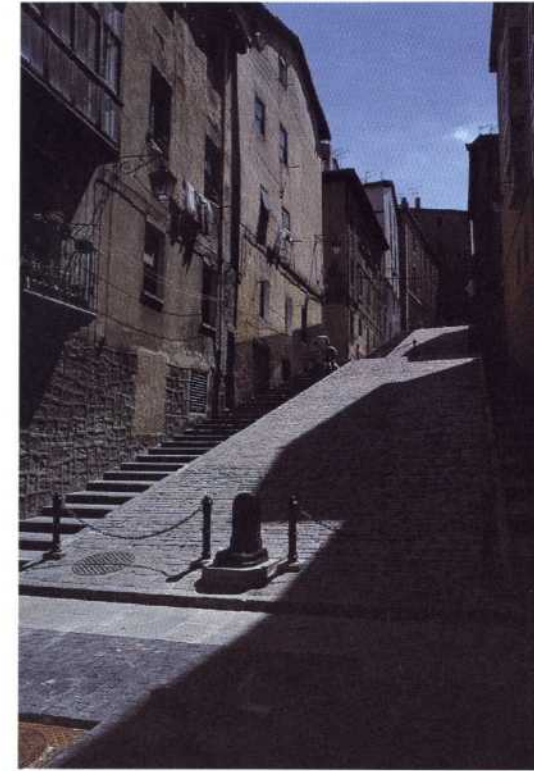
FIG. 10. Trabajos de pavimentación.
