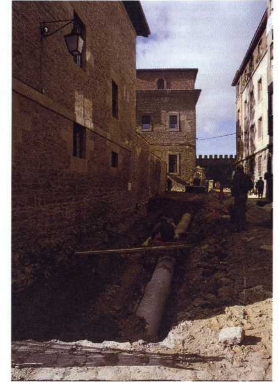
FIG. 11. Trabajos de infraestructura.
