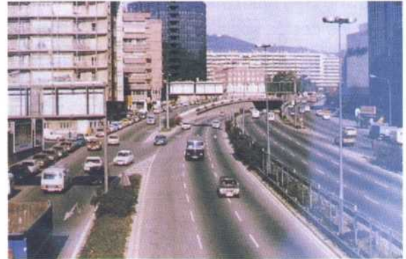
FOTO 4. En el tramo Plaça Cerdá-Manuel Girona el trazado es propio de una autopista urbana (túneles, accesos, etc.) (*).
