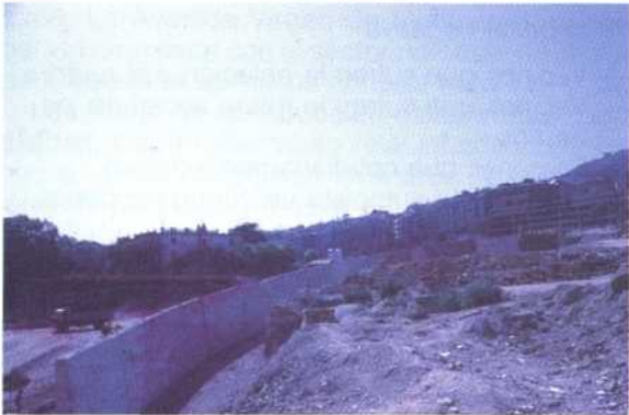
FOTO 18. Obras de enlace del I Cinturón con la boca sur del Túnel de la Rubira (*).
