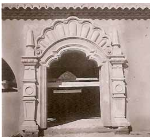
FIG. 8/ Casa del Guarda en construcción.
