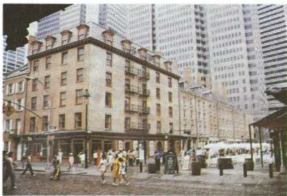
SEAPORT (Nueva York). Manzana de casas después de la restauración
