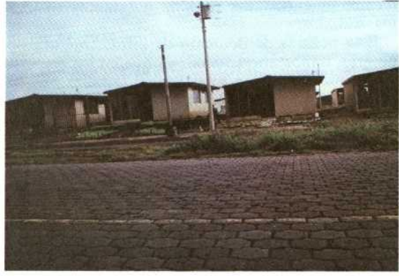
Viviendas individuales para técnicos al Este de Managua, en la carretera del aeropuerto.
