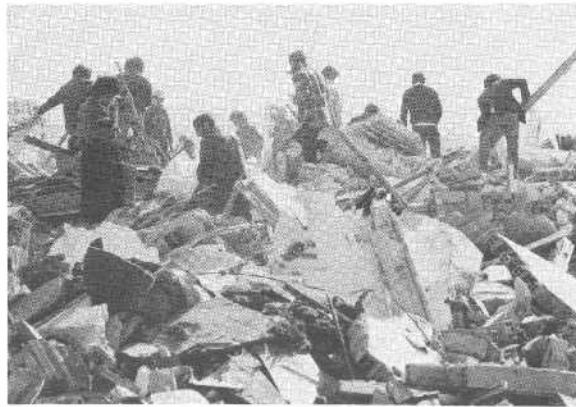
En torno a los derribos de las distintas áreas de infravivienda se organizan «cuadrillas» que se dedican a rescatar entre los escombros todo aquello que consideran reutilizable, constituyéndose un singular «mercado» de materiales constructivos.
