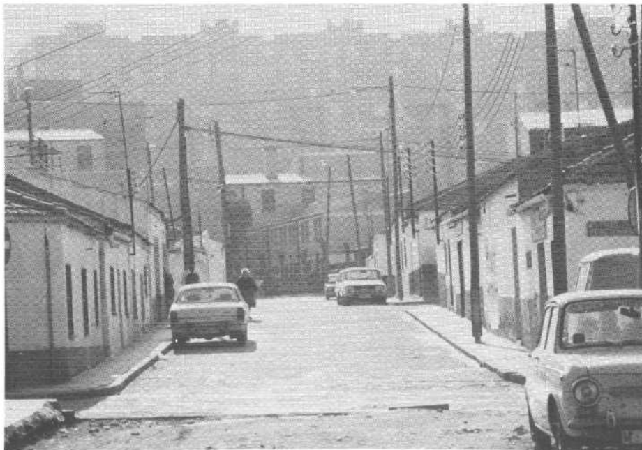
Viviendas de autoconstrucción. A pesar del cuidado aspecto estético de las encajadas fachadas, las precarias condiciones de habitabilidad eran inaceptables y en un alto porcentaje las viviendas resultaban irreversibles mediante rehabilitación.
