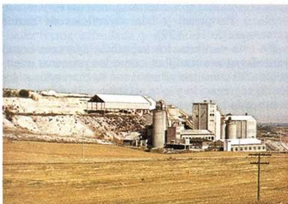
Fig. 7. Las margas son explotadas in situ por la fábrica de cemento. Zaratan.
