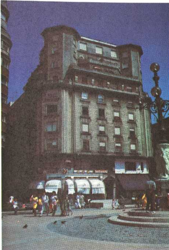
Un ejemplo del incremento de alturas de la edificación por el sistema de retranqueos.
