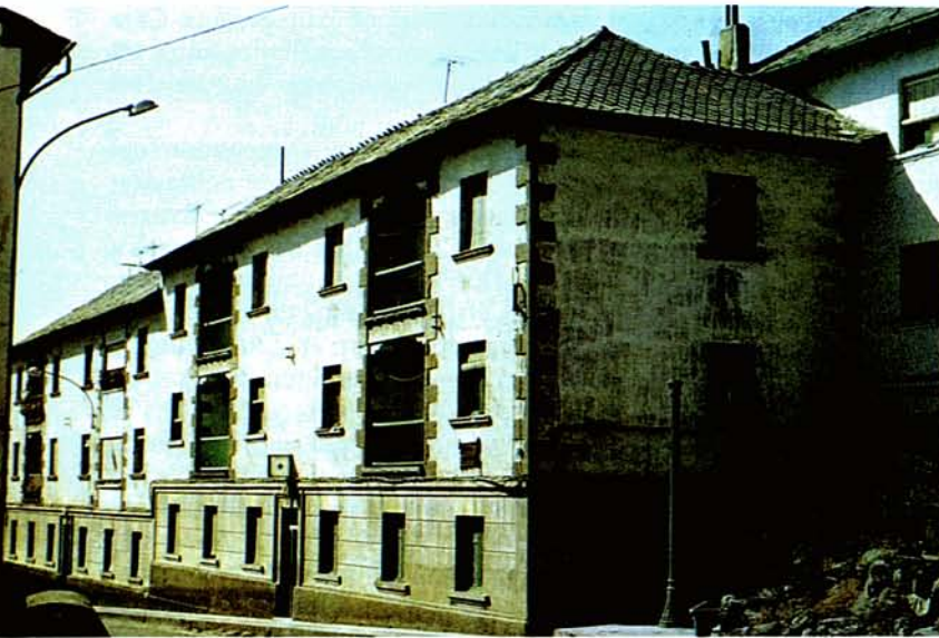
Las formas del crecimiento urbano. Arquitectura "moniañesa" en Villablino (Villablino). (1982)
