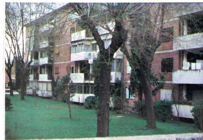
Cuartel de la Montaña: espacios libres muy bien cuidados entre bloques de doble crujía.
