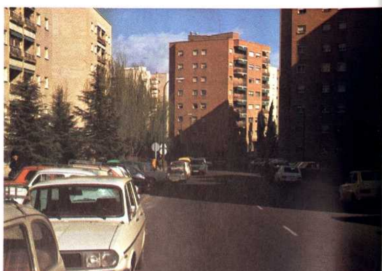
Manoteras II: eje viario principal. Escasez de aparcamientos.
