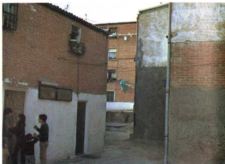
Fuencarral Poblado de Absorción: espacios entre bloques de doble crujía.
