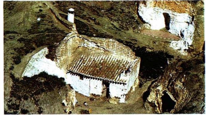
En otros casos la cueva se prolonga decididamente y de zaguán inicial puede surgir otra habitación exterior. pero el total de la vivienda se extiende más adentro en la roca a la que aparentemente solo esta adosada.
