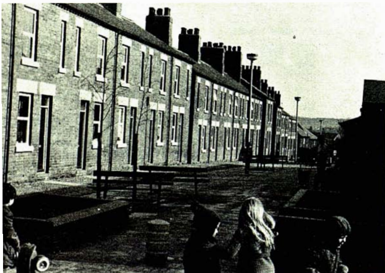
7a) Casas construidas en los 1860, después del proceso de rehabilitación.
